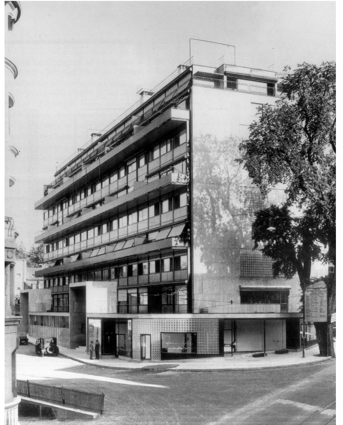
IMMEUBLE CLARTÉ, GENEVE La Restauration des années 2000
